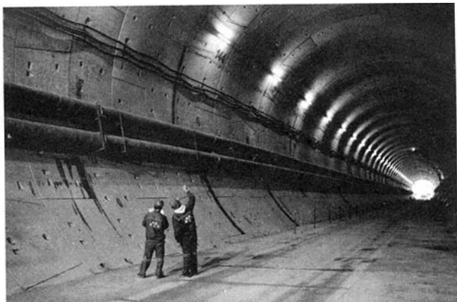
建设中的上海上中路隧道股份占领超大直径盾构法隧道领域的突破
