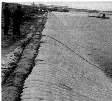
图1 模袋混凝土护坡
