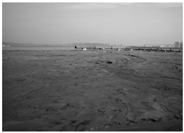
图 6 吹填后沙滩及排水
