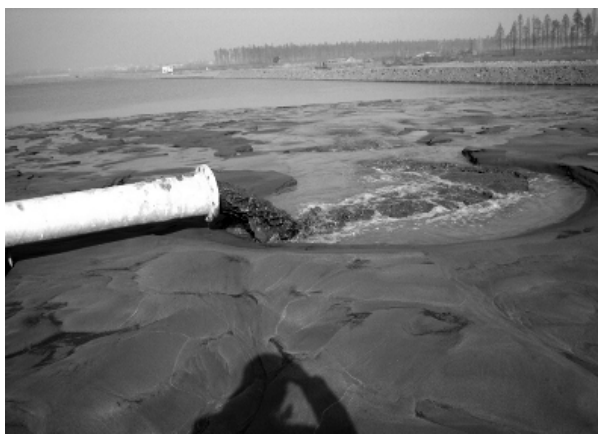
图 5 吹填泥砂
