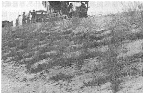
图 1 包头~东胜高速公路坡面新插沙柳网格
